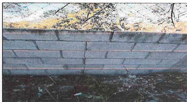
Reparación de muro perimetral, incluye repello, reparacion de columnas.
