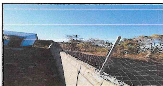
Colocación de tubos galvanizados para tenzar malla en muro perimetral
