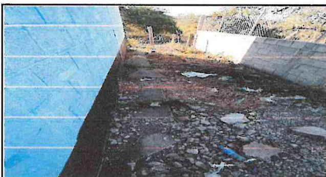
Reparación de 10 metros de planchas de concreto en patio perimetral.
